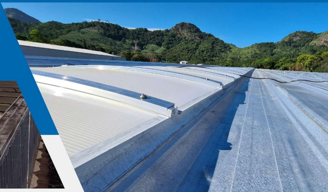
Os Domus Replaex foram desenvolvidos para ser manipulados com todas as telhas do mercado: Trapezoidais, em fibrocimento, em sistema Roll-on, zipadas e auto-portantes, pré-moldadas, termoacústicas e cobertura de passarelas.
